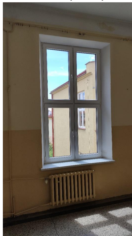
Widok wewnątrz – II Piętro
